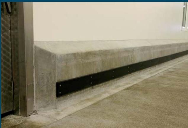
Anstelle der gemauerten Wände kommen hier Sandwichwände zum Einsatz. Sandwichplatten gibt es in verschiedenen Ausführungen z.B. Metallbeschichtung oder GFK (Glasfaserverstärkter Kunststoff). Vorteile der Sandwichplatten:
