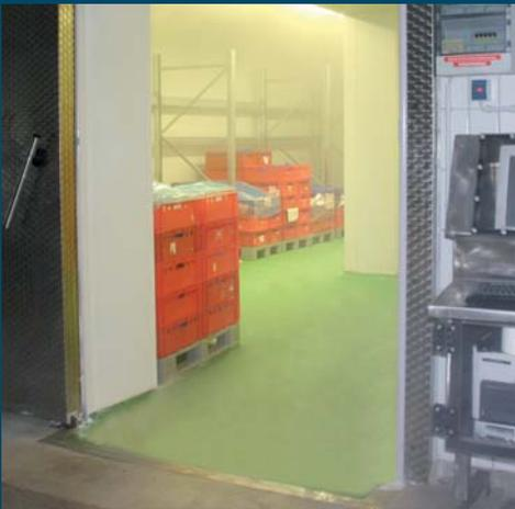
Austauschen des Fußbodens im Gefrierraum inklusive der Beschichtung und dem Einbau einer Kühlhaustür mit Rahmen- und Fußbodenheizung.
